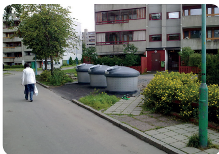
Till höger: Delvis nedgrävda behållare med enkroksystem för tömning.
