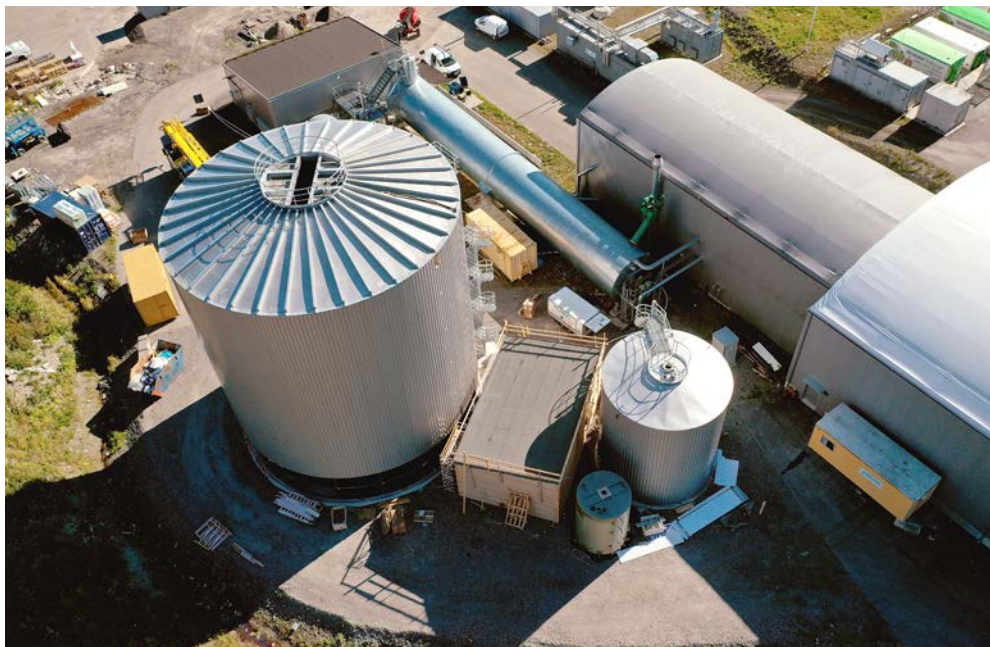
Biogasanläggningen i Äland byggdes ut under 2022 för att kunna ta emot matavfall från fler kommuner.
