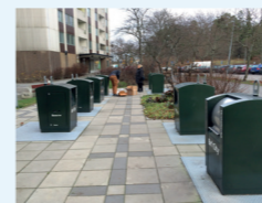
Helt nedgrävda underjordsbehållare.
